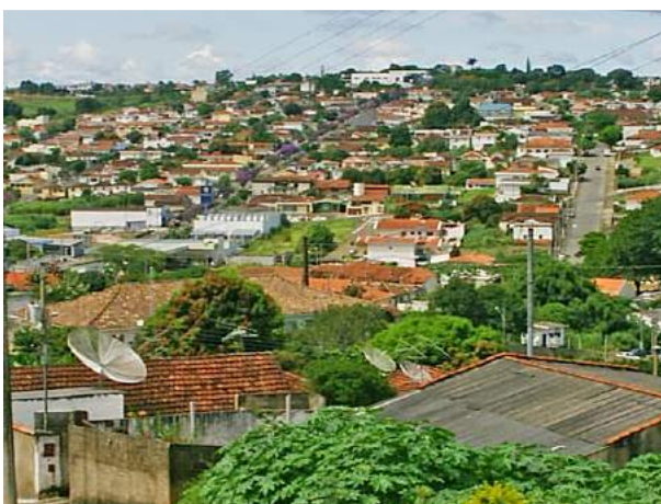
Vista parcial da cidade de Guaxupé – área residencial Fotógrafo: Vinicius Passos Data: Março de 2006
