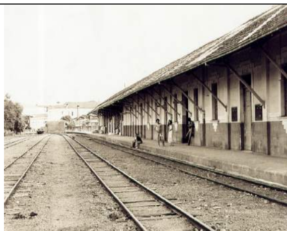
Estação de Trem - FEPASA Acervo do Departamento de Cultura de Guaxupé Sem Data
