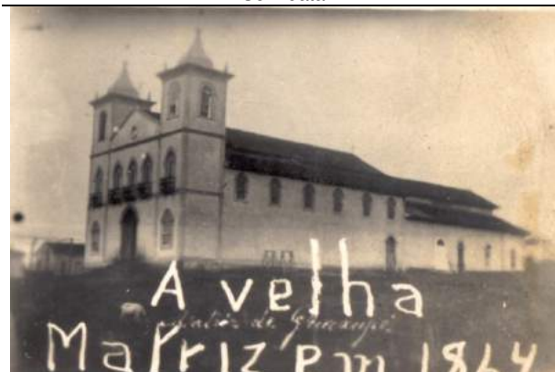
Antiga Matriz demolida para construção da nova. Acervo do Departamento de Cultura de Guaxupé Data: 1864
