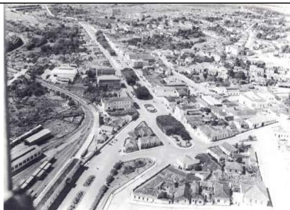
Praça Paulo Carneiro encontra com Avenida Conde Ribeiro do Valle – Complexo da FEPASA Acervo do Departamento de Cultura de Guaxupé Sem Data
